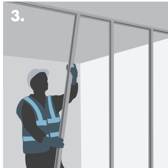
3. Twisting Knauf 'C' Stud into position.
